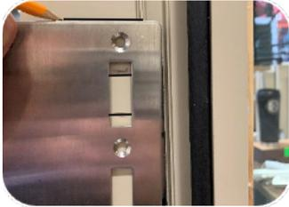
**ALIGN THE STRIKE PLATE WITH THE DEADBOLT MARKS. MARK THE TOP OF THE PLATE.**
